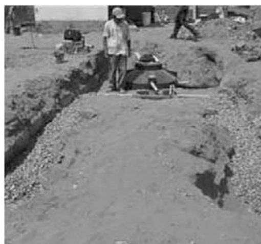
Zanja de infiltración
