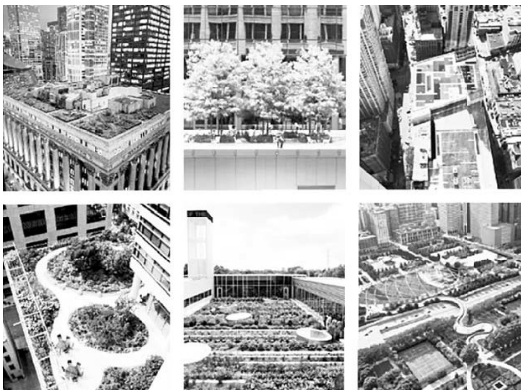
Figura 3 – Terraços e telhados verdes (Chicago, Estados Unidos).
