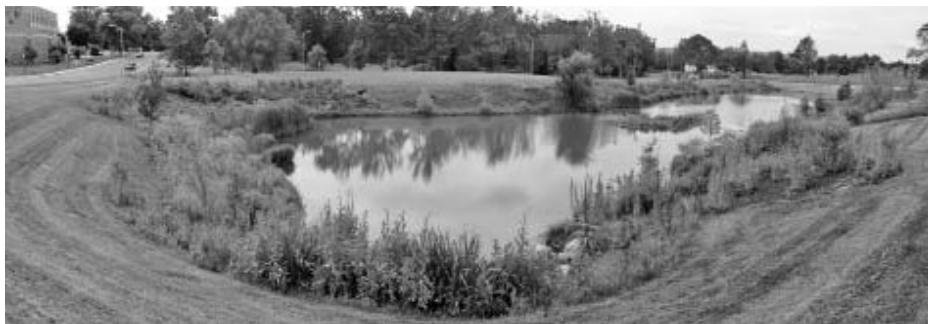
Figura 11 – Depósito superficial de detenção. Fonte: Internet. 26
